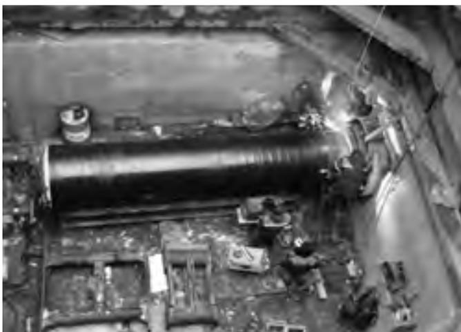
**Рис. 6** Механизированная сварка порошковой проволокой подземного газопровода
