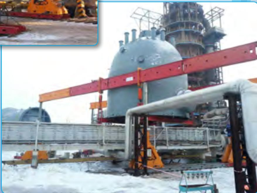
Монтажно-такелажными работами с негабаритными и тяжеловесными грузами называют комплекс мероприятий, направленных на поднятие, перемещение и установку объектов на фундамент. На фотографиях запечатлен момент переноса объекта через эстакаду. Работы производились с помощью собственного специального оборудования: специализированные комплекты домкратов, системы горизонтального перемещения Skidding System и гидравлической портальной системы SBL 1100, грузоподъемностью до 1100 т.
