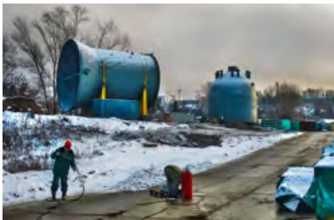
**Фото 2.** Нижняя часть регенератора поступила в горизонтальном положении. Её требовалось поставить вертикально
