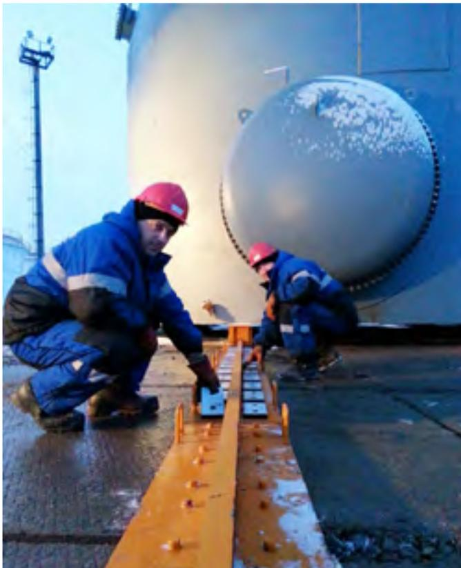
**Фото 6.** Система горизонтального скольжения, скользящие фторопластовые пластины
