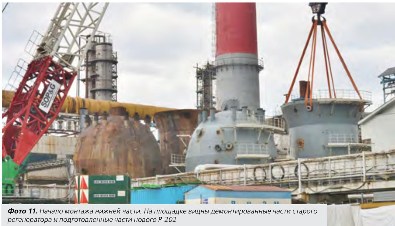
**Фото 11.** Начало монтажа нижней части. На площадке видны демонтированные части старого регенератора и подготовленные части нового Р-202
