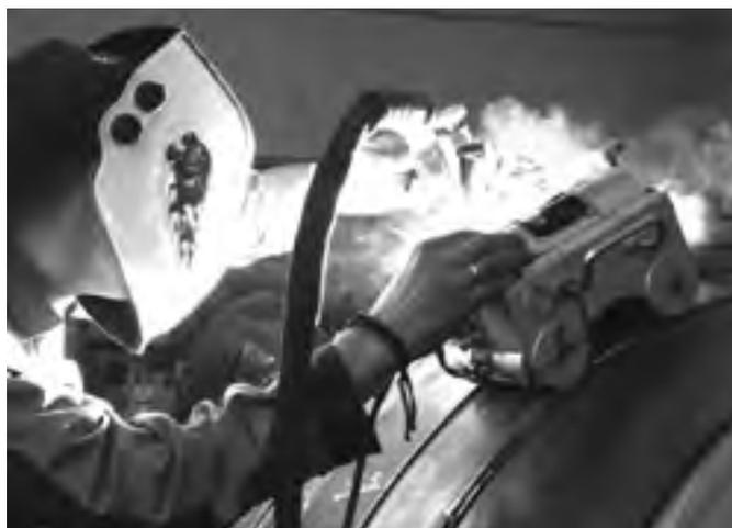
**Рис. 9** Процесс сварки кольцевого стыка изолированных труб 1220x16 с помощью магнитной каретки
