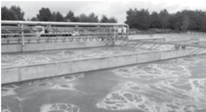
Процесс аэрации, ОС г. Томашув-Мазовецки
