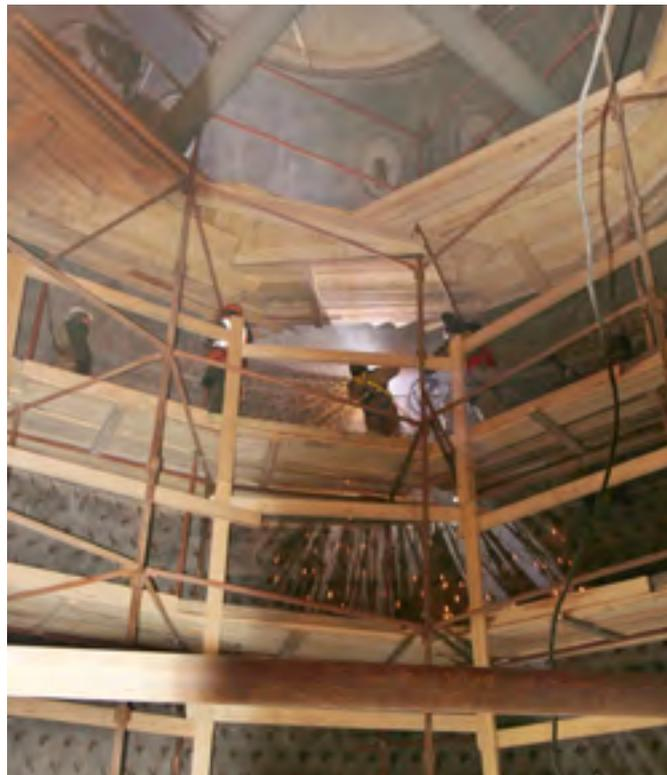
**Фото 7.** Приваривание анкеров. На верхнем куполе Р-202 их должно быть 11 тысяч штук, на нижнем – 12 тысяч. Непосредственно на объекте трудится 47 человек, из них 9 – сварщиков.
