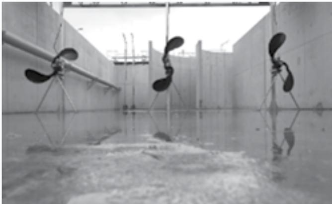
Агитаторы потока Grundfos на ОС г. Томашув-Мазовецки
