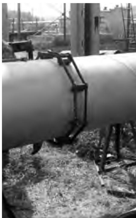
**Рис. 12** Сборка и сварка теплотрассы в полевых условиях с использованием магнитной каретки
