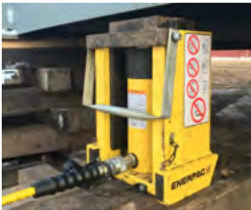
**Фото 3.** Конструкция поднимается домкратами, затем под неё загоняется модульная гидравлическая тележка
