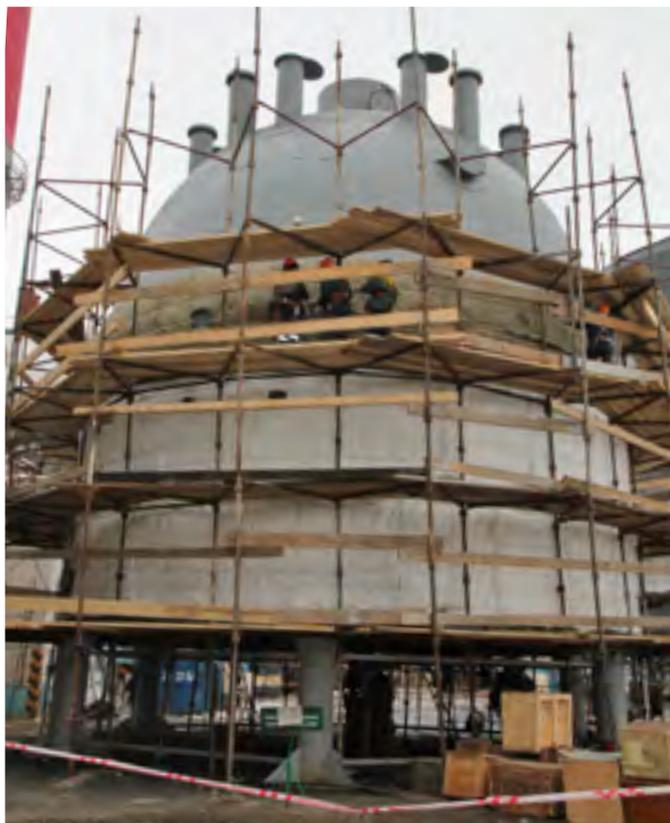
**Фото 8.** Новая верхняя часть, установлена на стапели для монтажа циклонов
