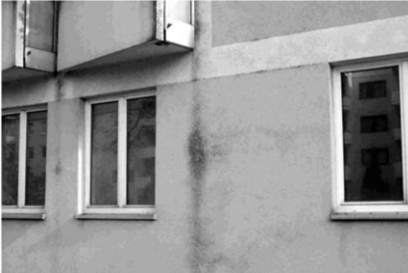
Рис. 7. Локальное образование водорослей, вдоль участка с концентрацией на пути стока дождевой воды, вызванного боковым ограничением балконов и ветром. Рост водорослей явно менее интенсивен непосредственно в областях под балконной плитой, чем на незащищенных участках.
