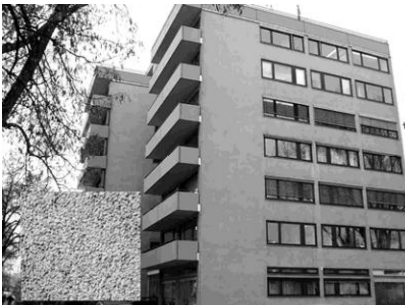
Рис. 4 Восточный и южный фасады (справа налево) объекта 54 в Ноймаркте в декабре 2004, спустя 16 лет после ремонтных работ, заключавшихся в наложении нового покрытия. В левом нижнем углу – приближенное изображение штукатурки над маленьким окном.
