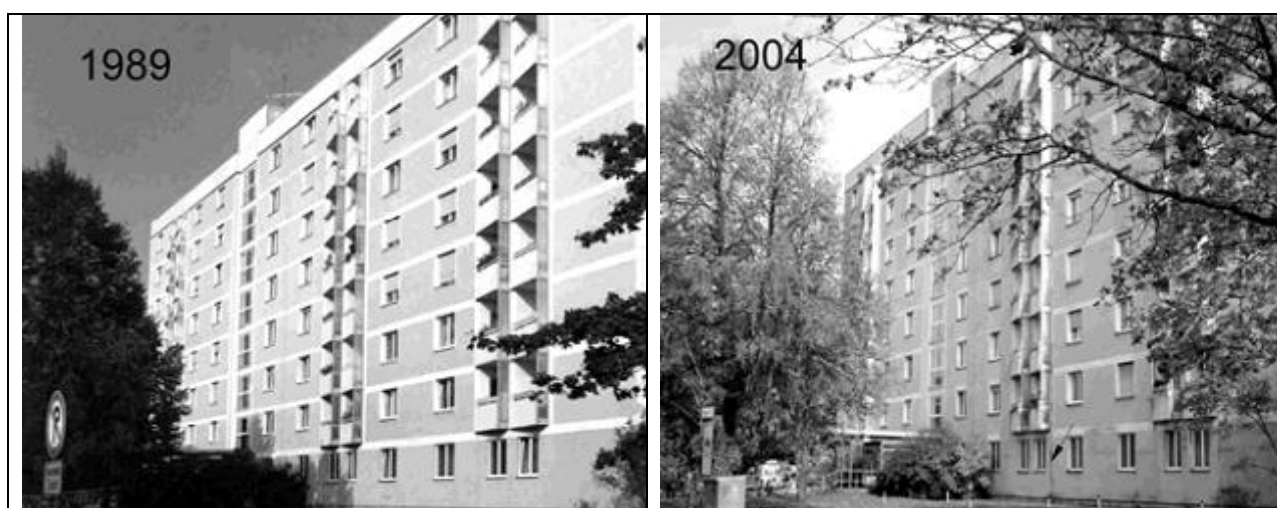
Рис. 6 Западный фасад объекта 16 (Дом Престарелых в Мюнхене), в сентябре 1989, спустя 3 года после применения СФТК и спустя 15 лет в Ноябре 2004. Различие в цвете фасада не означает, что здание было перекрашено, а связано с качеством цифровой фотографии. Образование водорослей четко видно, особенно на участках, подвергающихся интенсивному воздействию дождя (см. Рис. 7).
